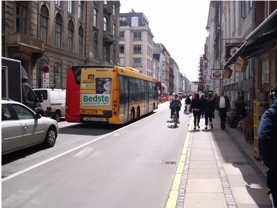
Baulich getrennter Radweg in Kopenhagen (Busse fahren auf der Fahrbahn)
