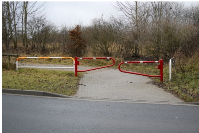
Umlaufsperrn sind für Radfahrende oft problematisch
